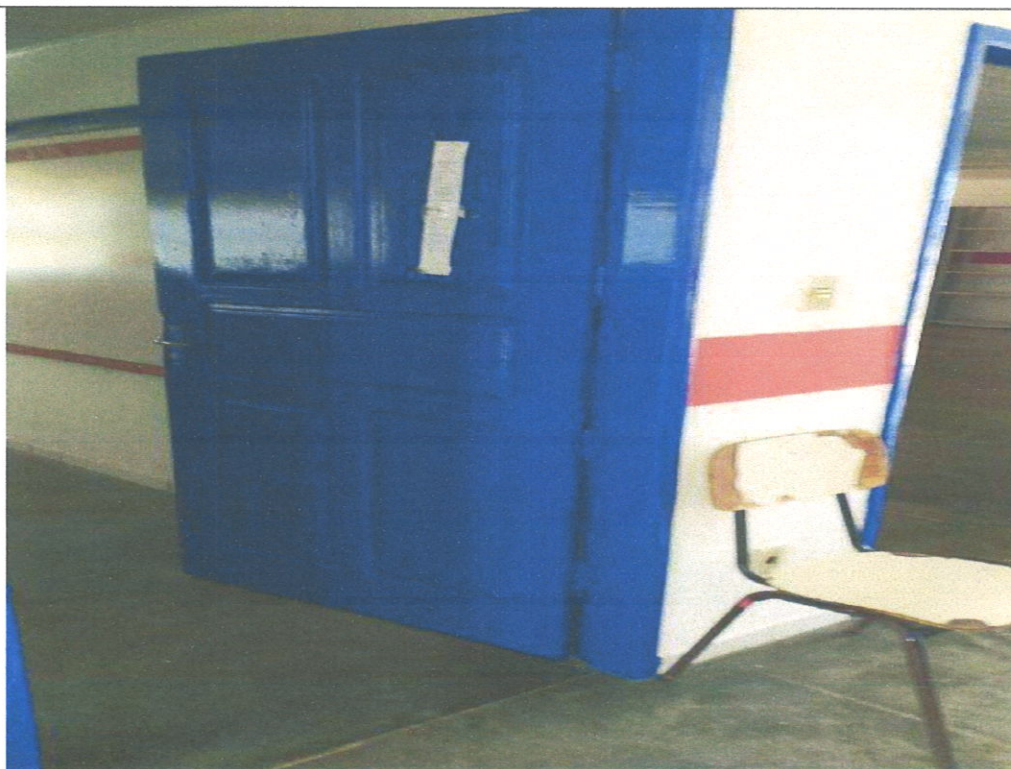
Execução de pintura em esquadrias.
