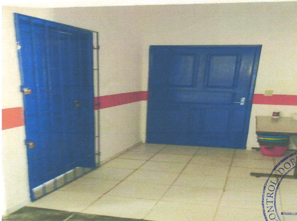
Execução de pintura em esmalte sintético
