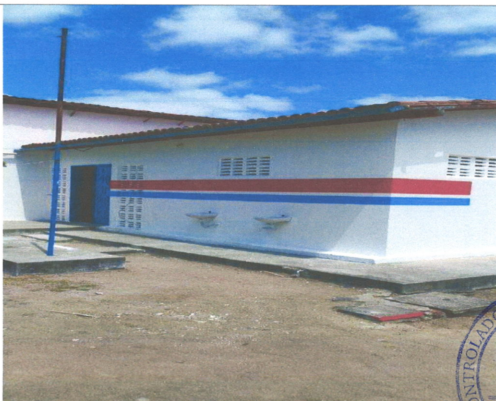
Execução de pintura latex.
