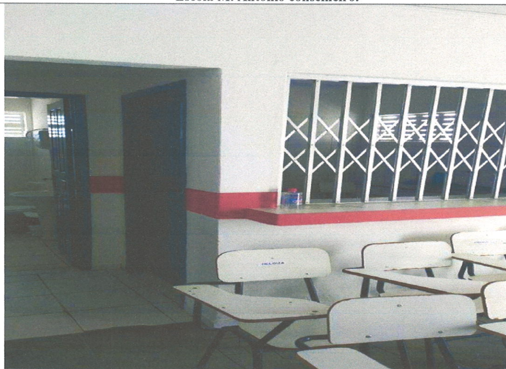
Execução de pintura em esmalte sintético.
